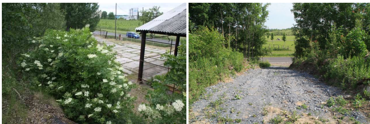
Obr. 42 a 43 : před křížením s Toužimskou je třeba řešit překonání výškového rozdílu a demolicí haly (přislíbil majitel pozemku SIT PRAGUE, a.s.), vpravo je dnes patrný průsek a rampa, která překonává výškový rozdíl
